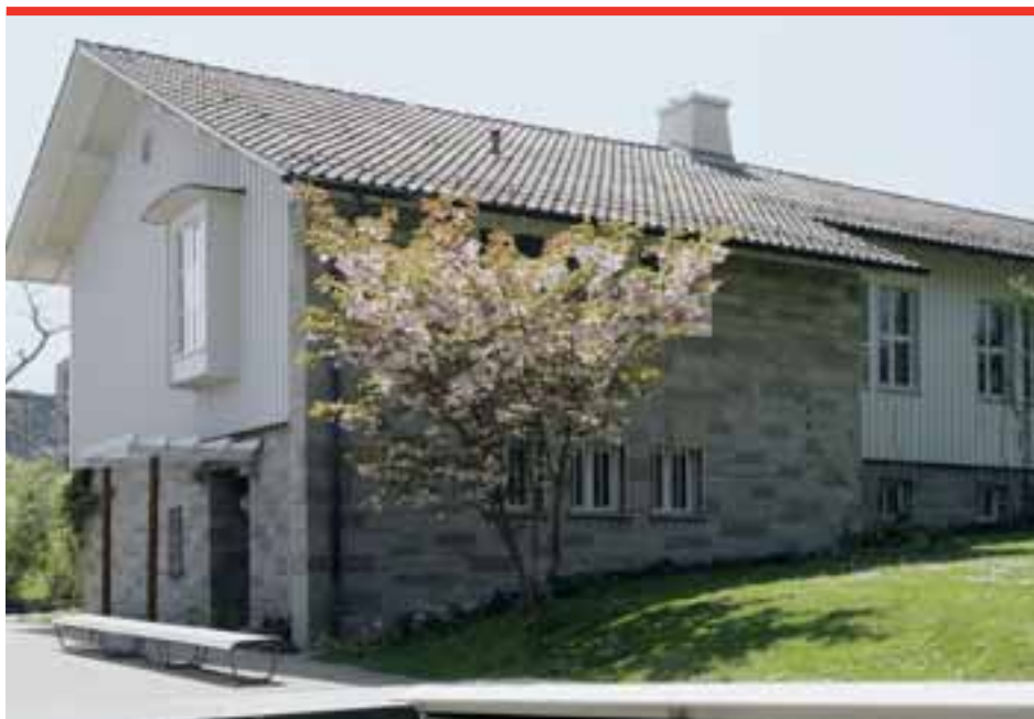
Hier weht noch der Landigeist: Das Zürcher Schulhaus Bachtobel (1947), ein Pavillonbau mit Holzlattenverkleidung.
