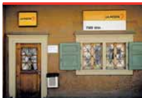
Auf der Liste der bedrohten Poststellen: 7149 Vrin (Kanton Graubünden). (Foto: Post)
